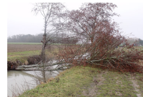
Embâcle à supprimer – source DDT
